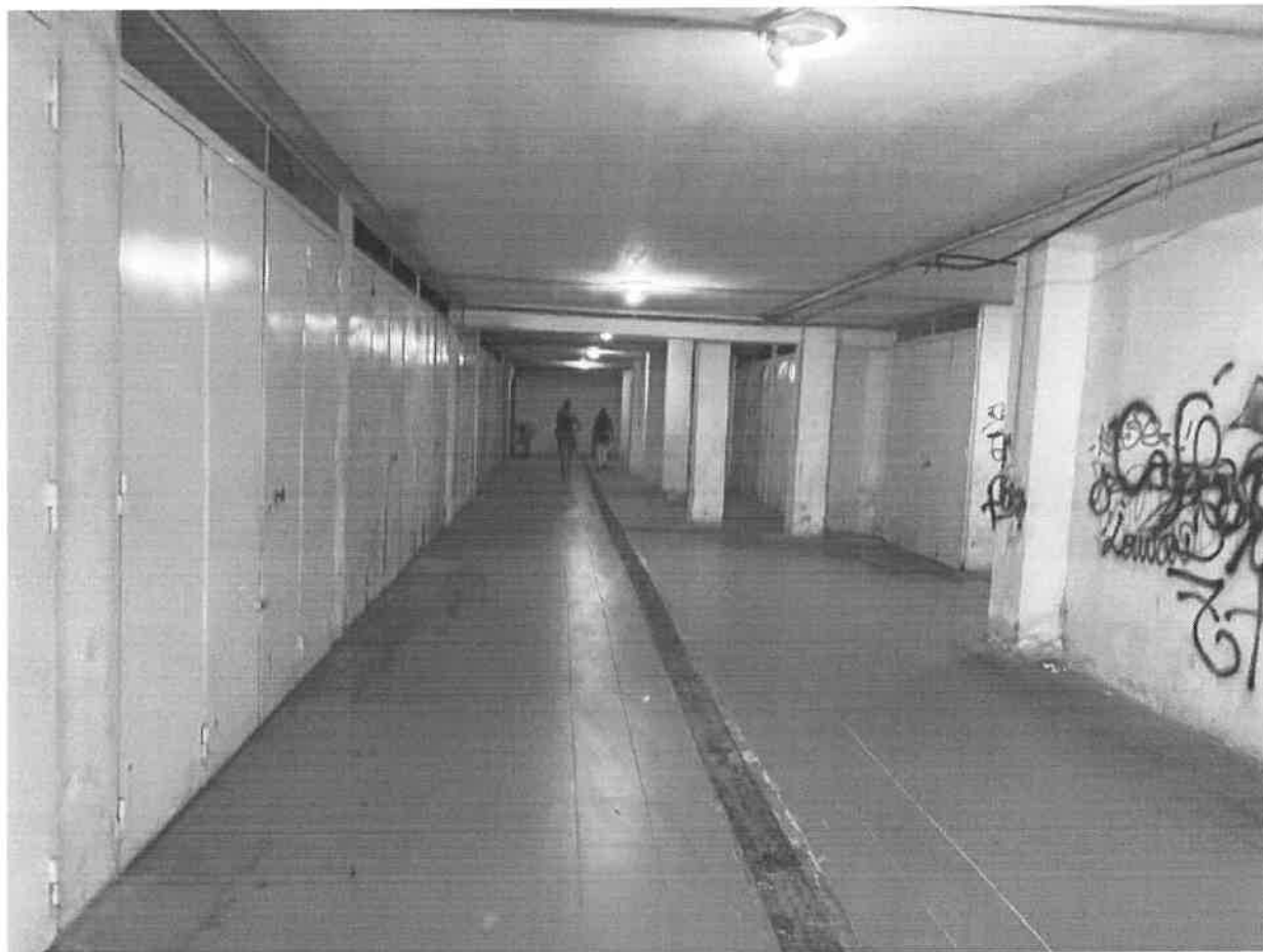
FOTO n. 4 – Particolare corsia accesso box –
