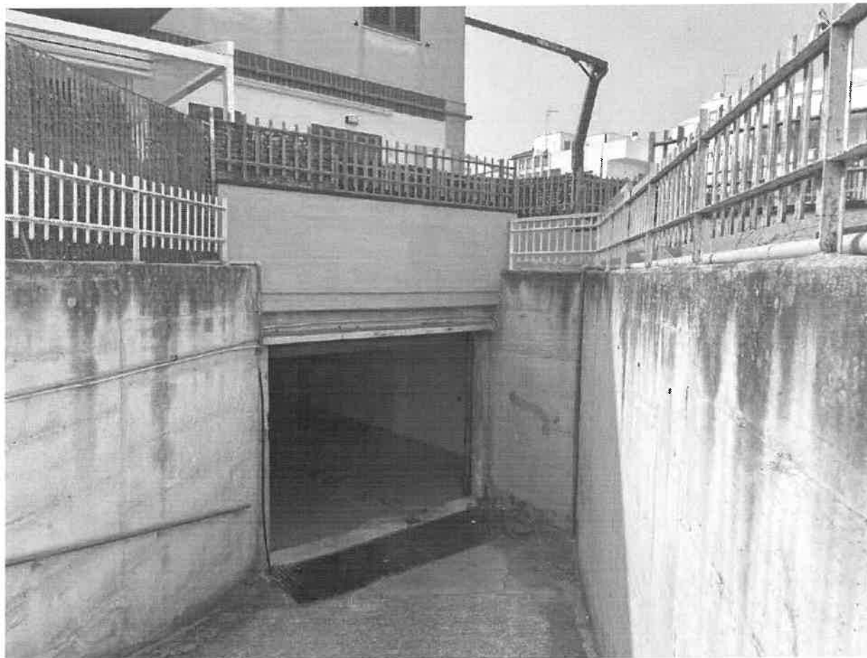
FOTO n. 3 – Particolare rampa e porta di accesso piano interrato –
